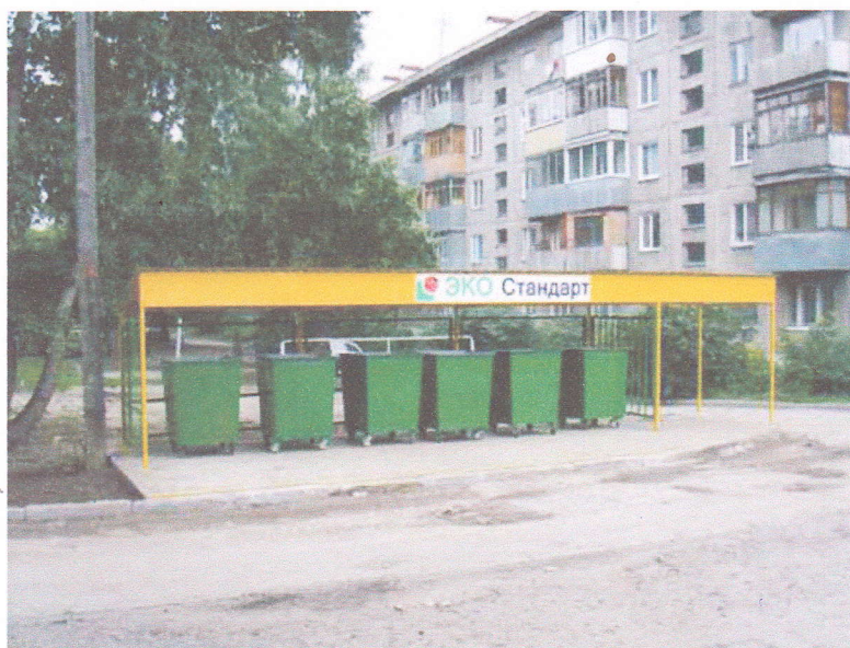
Рис. 4.20. Контейнерная площадка фирмы ООО «Эко-Стандарт»
